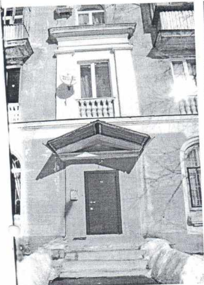
Фото № 9. Фрагмент главного фасада.
