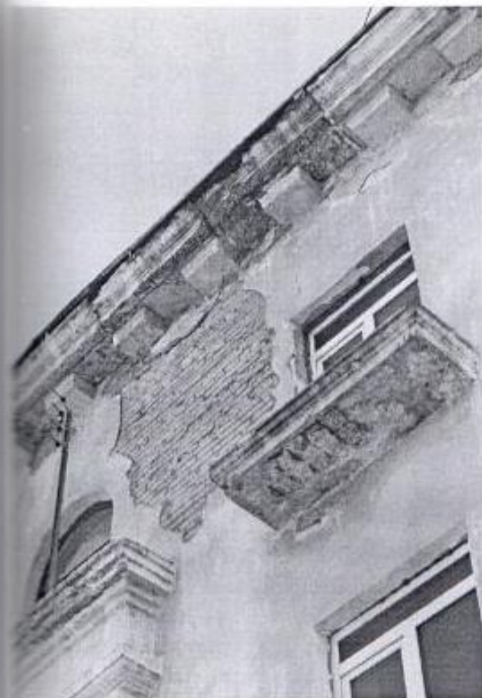
Фото № 17. Фрагмент дворового фасада.
