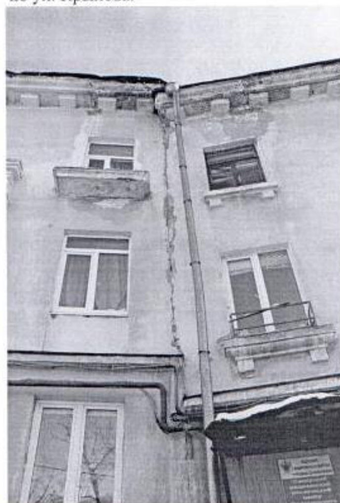
Фото № 16. Фрагмент дворового фасада.
