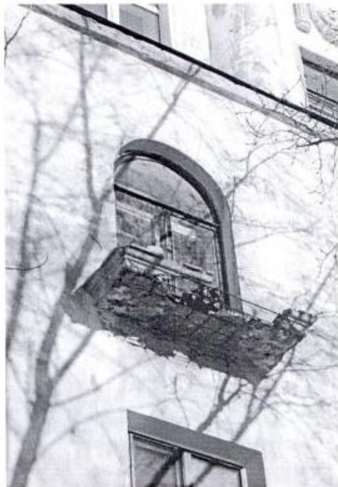
Фото № 18. Фрагмент фасада по ул. Носова.
