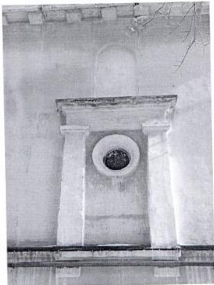
Фото № 22. Фрагмент торцевого фасада.
