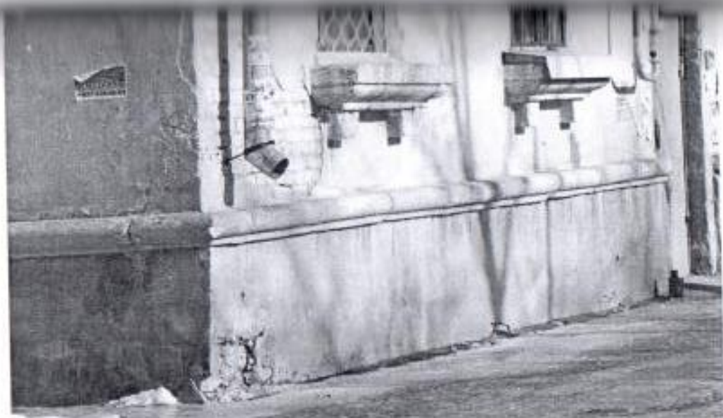
Фото № 33. Фрагмент дворового фасада.
