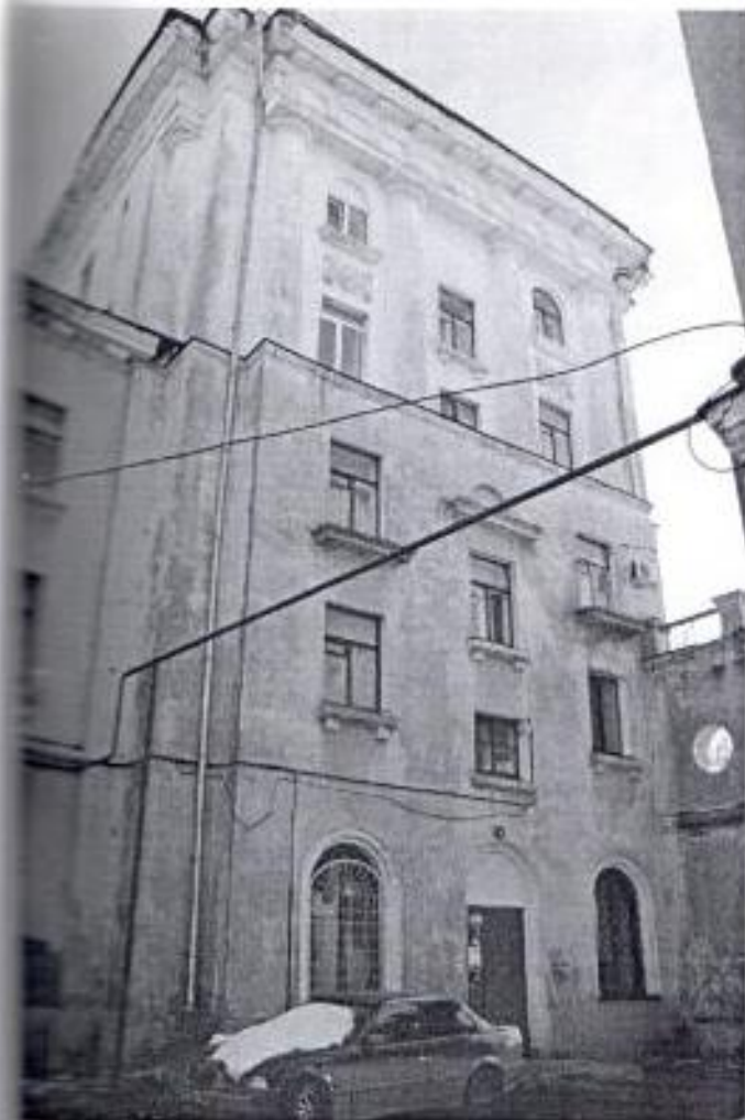
Фото № 9. Фрагмент дворового фасада.
