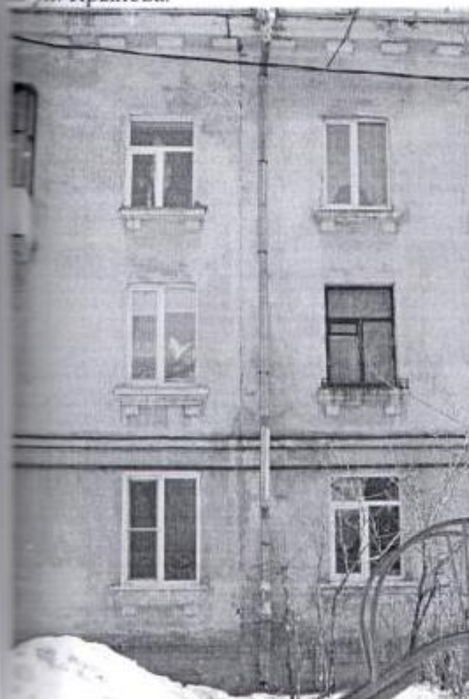
Фото № 15. Фрагмент дворового фасада .
