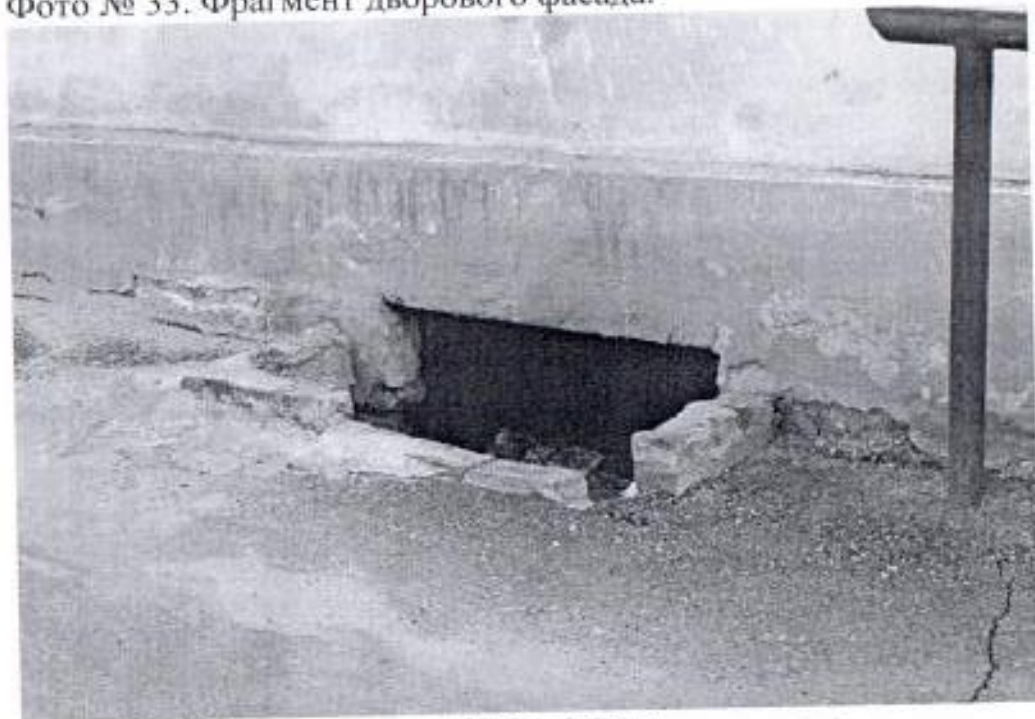
Фото № 35. Фрагмент дворового фасада.
