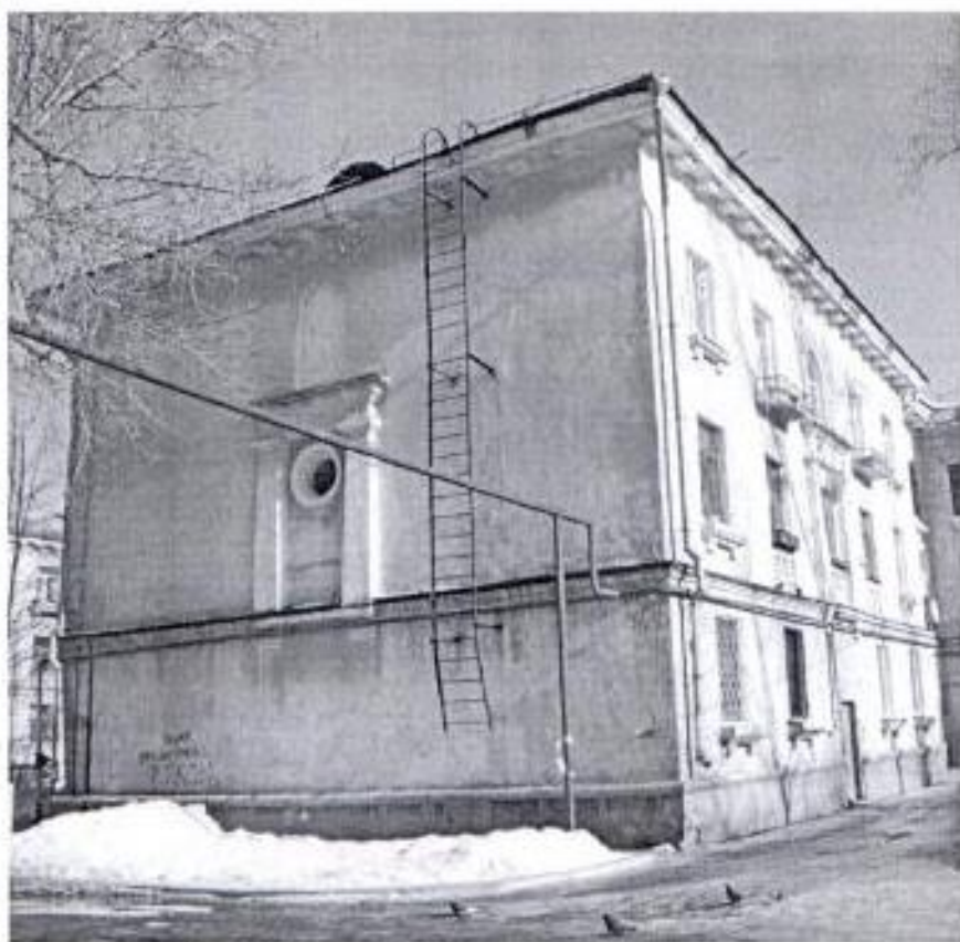
Фото № 5. Торцевой фасад.
