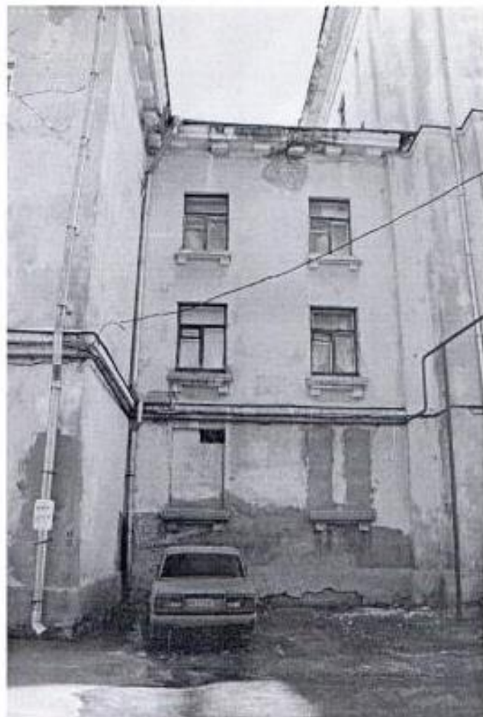
Фото № 10. Фрагмент дворового фасада.
