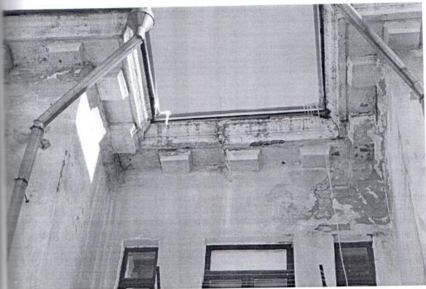
Фото № 23. Фрагмент дворового фасада.
