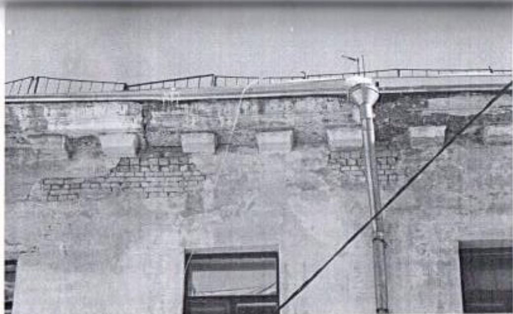
Фото № 28. Фрагмент дворового фасада.
