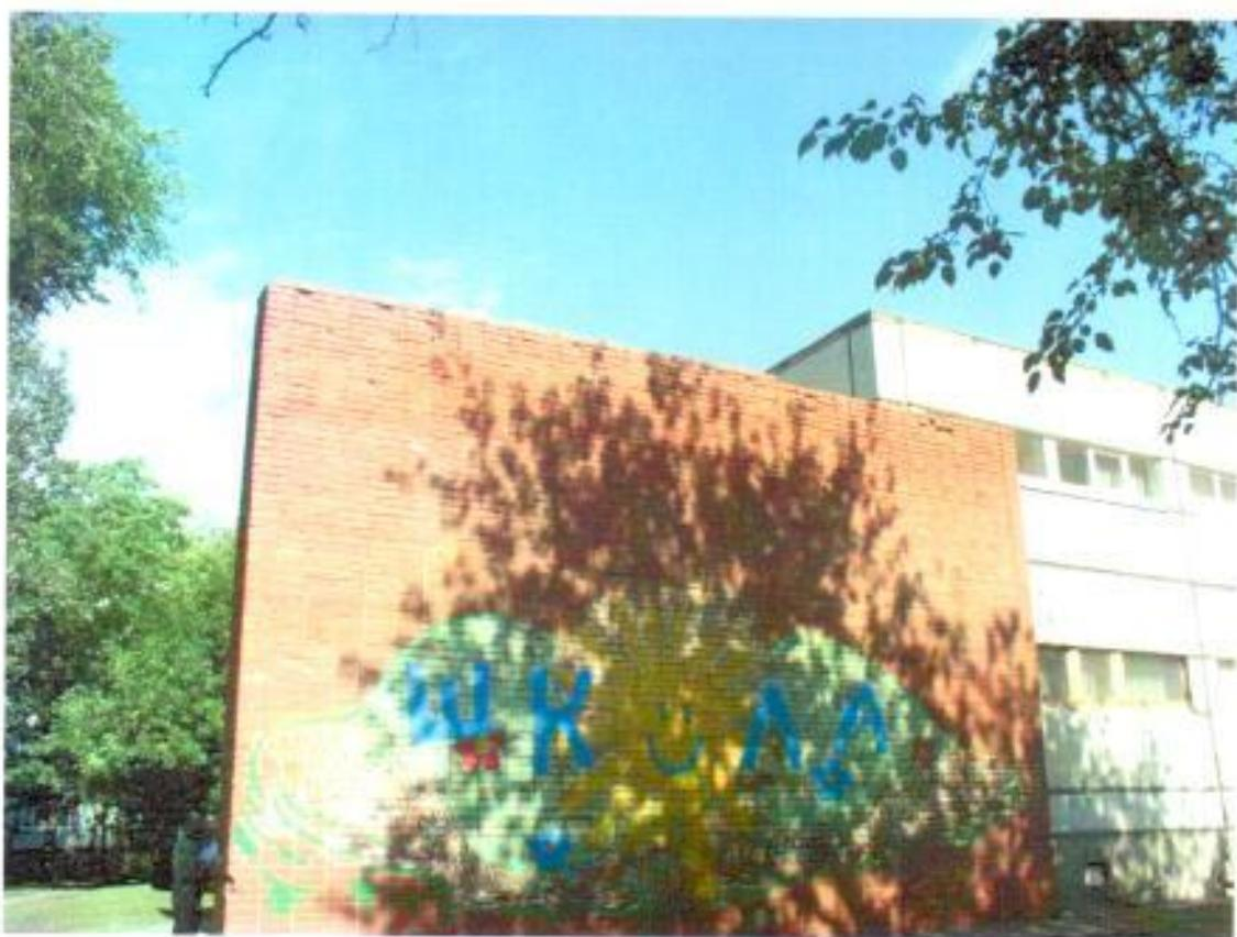
3.8. Стены наружные из панелей керамзитобетонных с облицовкой стеклоплиткой ( $15 \times 15$ ) дефектов и повреждений, влияющих на несущую способность – не имеют.
