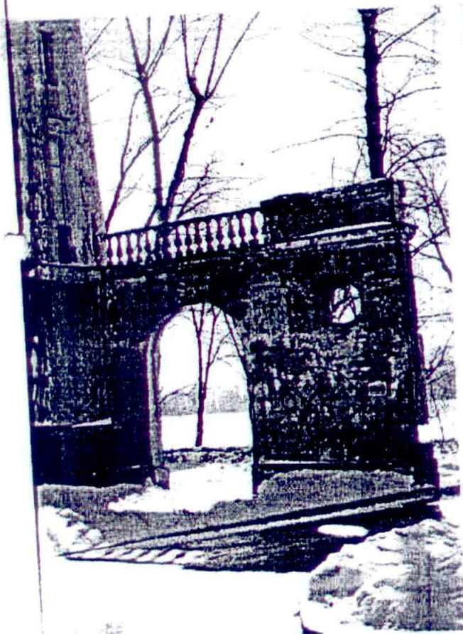
Фото № 14. Фрагмент дворового фасада.
