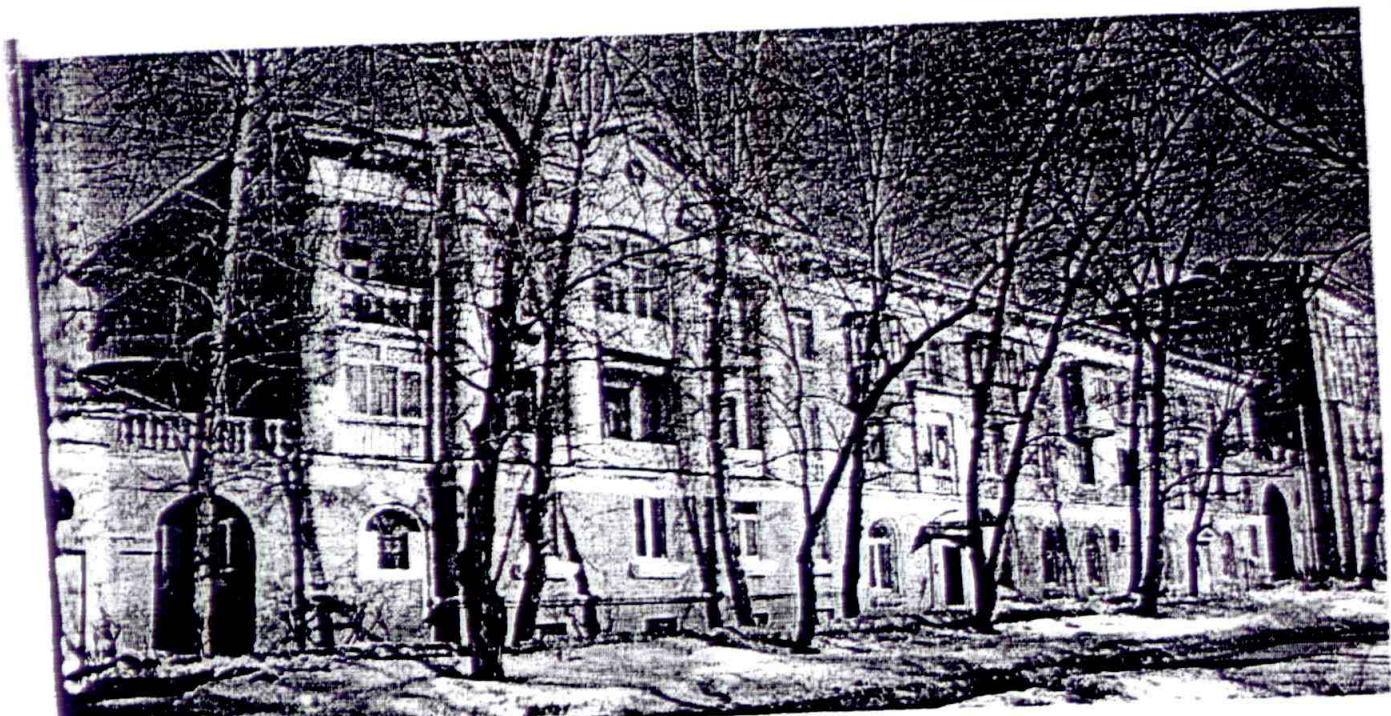
Фото № 1. Главный фасад по ул. Носова.
