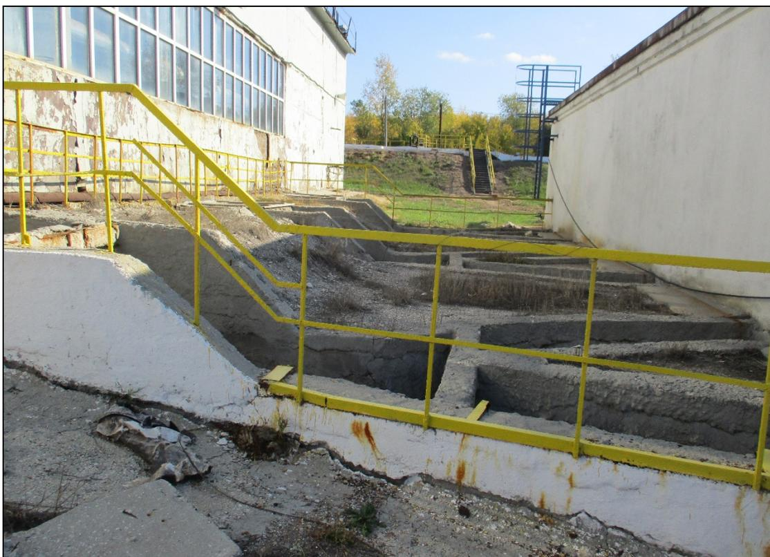
Рисунок 16 – Общий вид отводных каналов между зданием решеток и зданием управления песколовками
