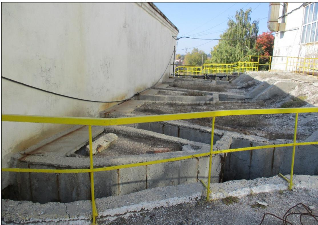
Рисунок 15 – Общий вид отводных каналов между зданием решеток и зданием управления песколовками
