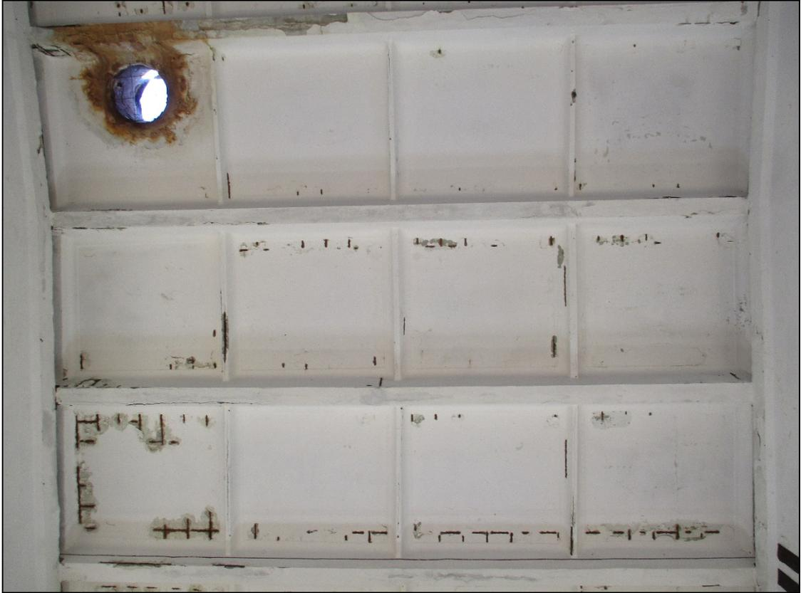
Рисунок 7 – Общий вид состояния плит покрытия в осях 2-6/А-Б
