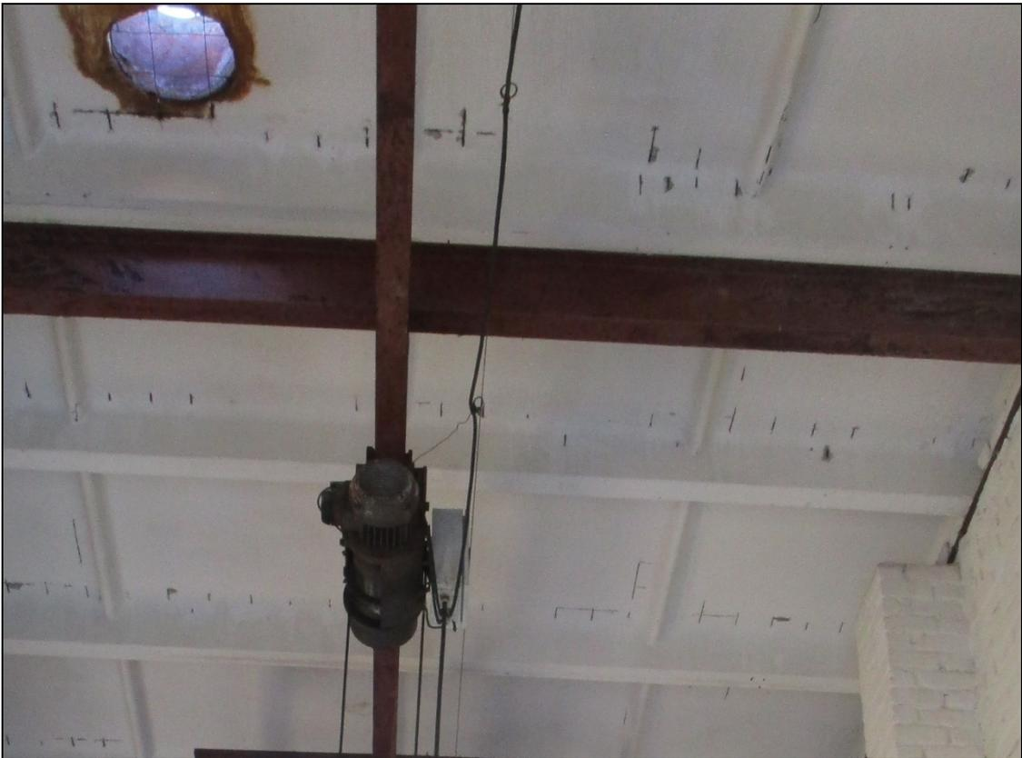
Рисунок 12 – Подкрановая и кран-балка в осях 6-7/А-Б
