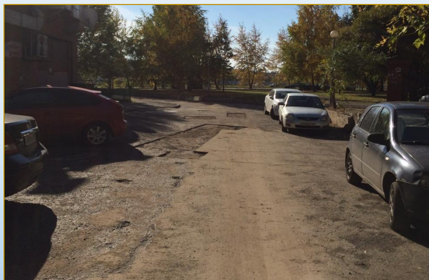
Фото объекта «В работе»
