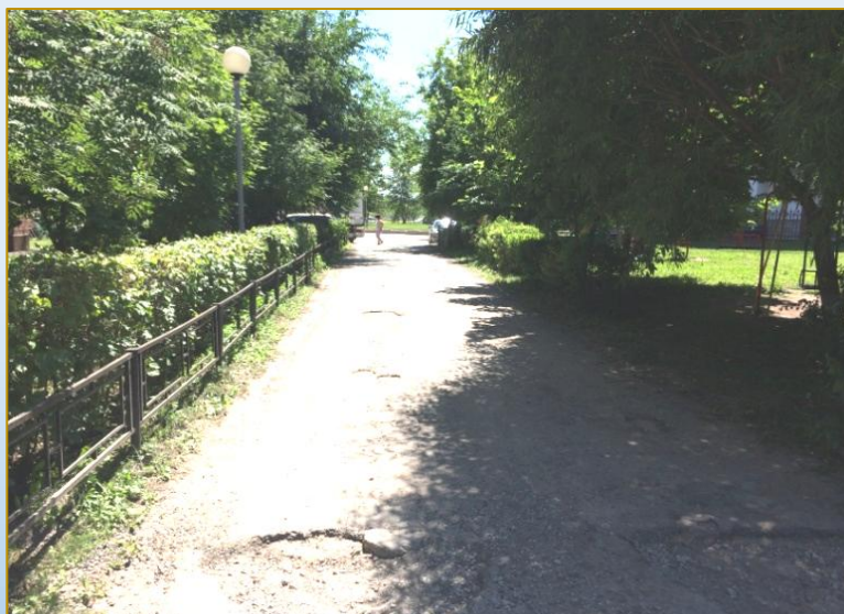
Фото объекта «До»
