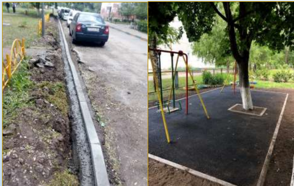
Фото объекта «В работе»
