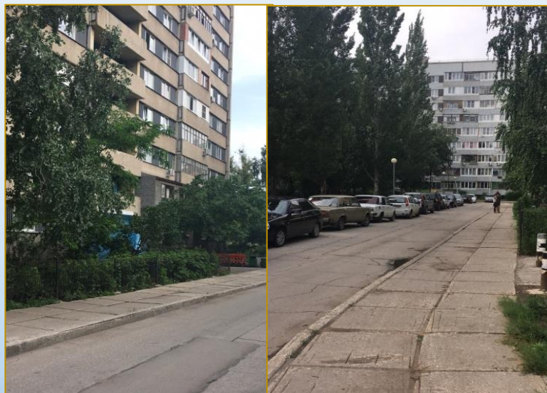
Фото объекта «До»
