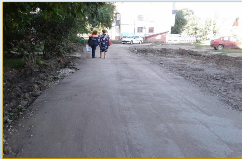
Фото объекта «В работе»
