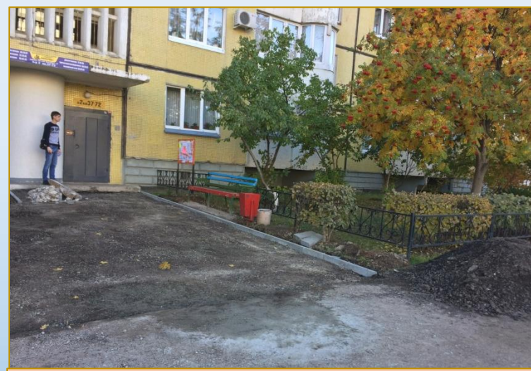
Фото объекта «В работе»
