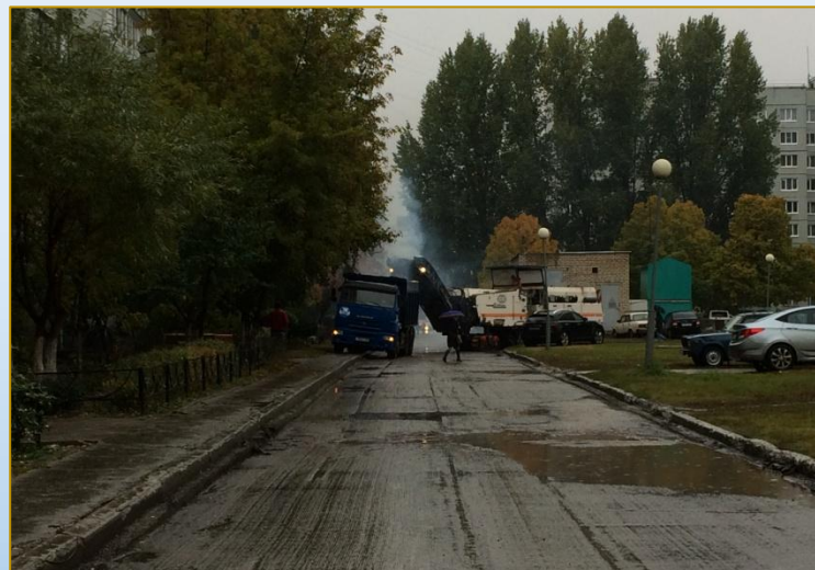
Фото объекта «В работе»
