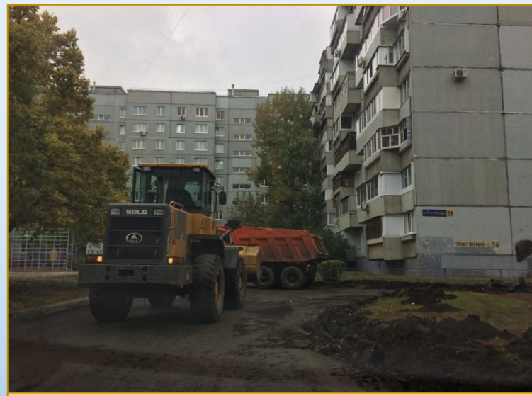
Фото объекта «В работе»
