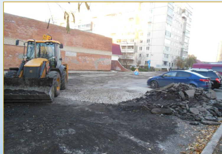
Фото объекта «В работе»
