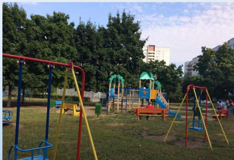
Фото объекта «В работе»
