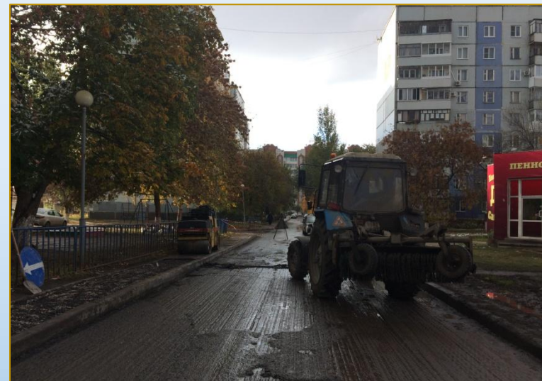
Фото объекта «В работе»
