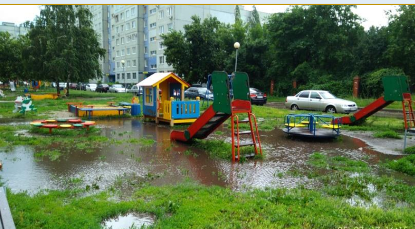
Фото объекта «До»
