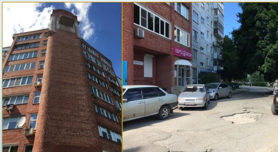
Фото объекта «До»
