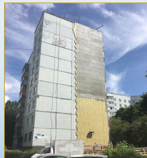
Фото объекта «В работе»
