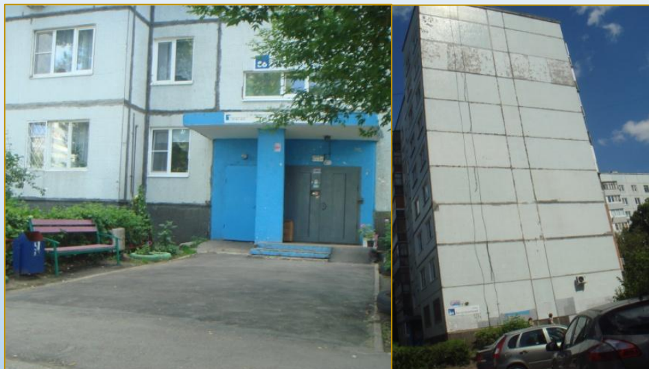
Фото объекта «До»
