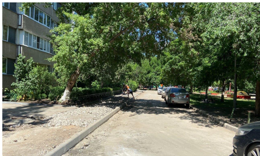
Фото объекта «В работе»
