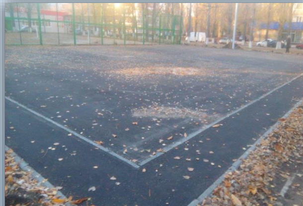
Фото объекта «В работе»
