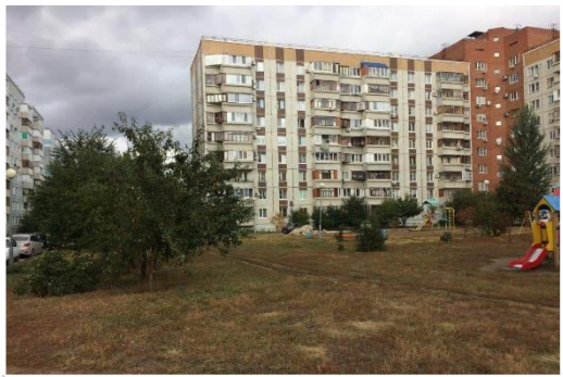
Фото объекта «До»
