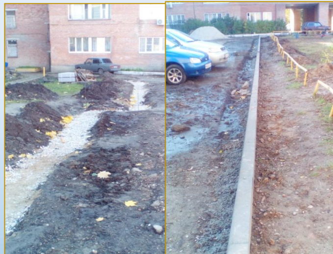
Фото объекта «В работе»
