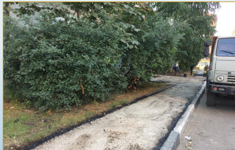
Фото объекта «В работе»
