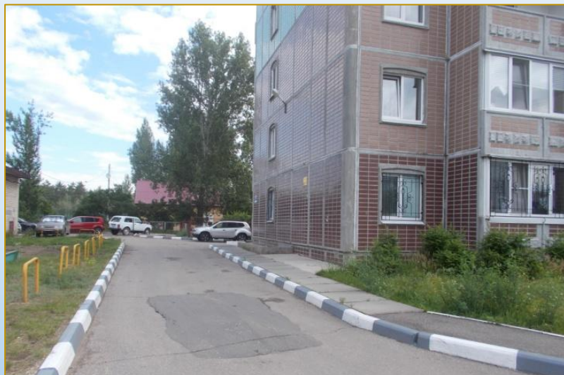
Фото объекта «До»
