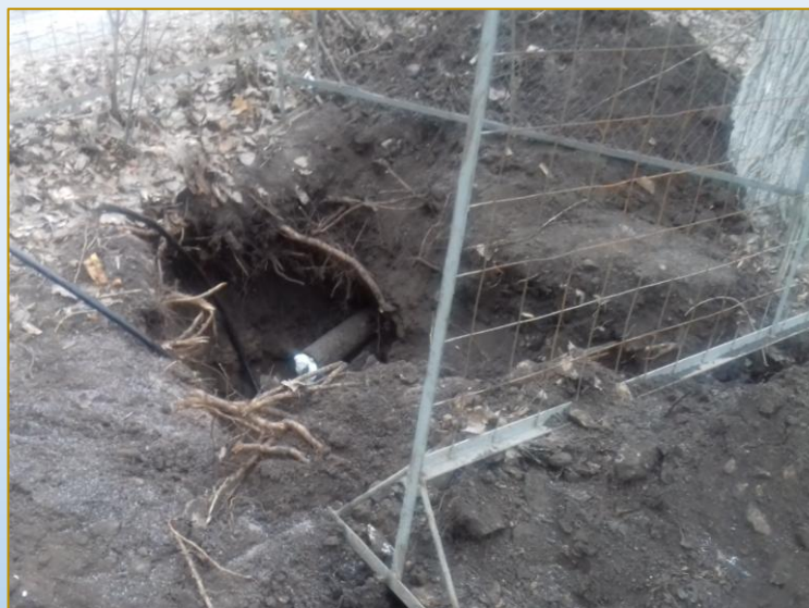
Фото объекта «В работе»
