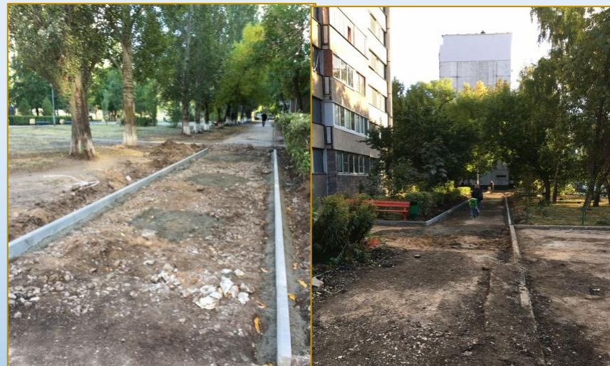
Фото объекта «В работе»
