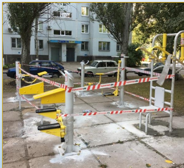
Фото объекта «В работе»
