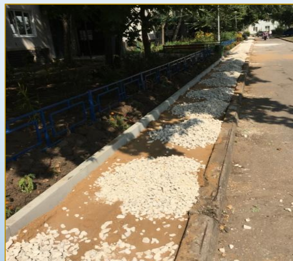
Фото объекта «В работе»
