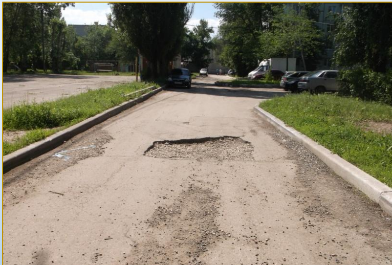
Фото объекта «До»
