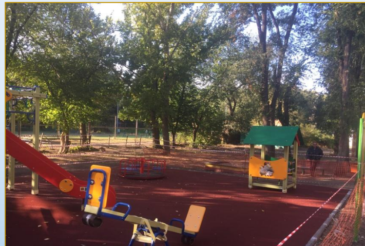
Фото объекта «В работе»
