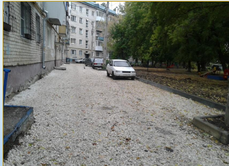
Фото объекта «В работе»
