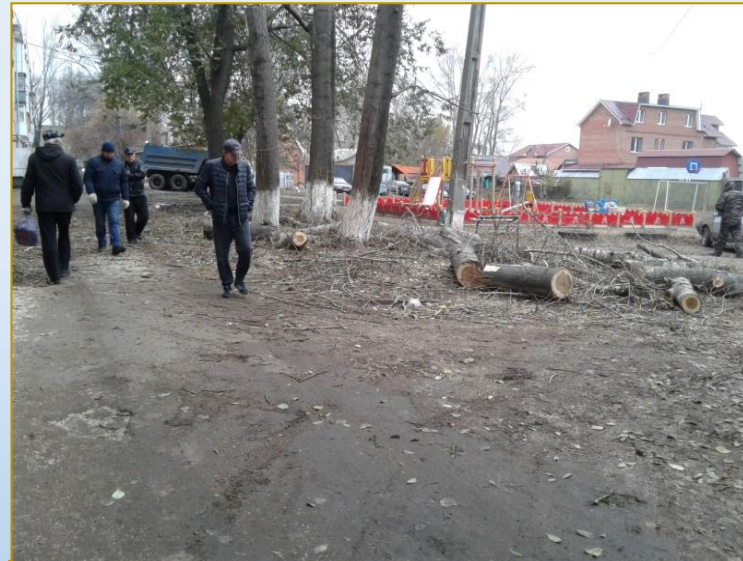
Фото объекта «В работе»
