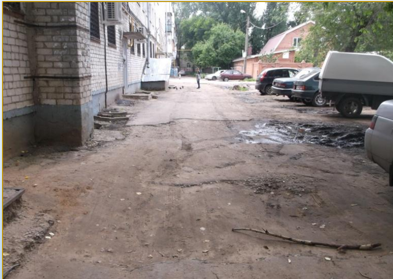
Фото объекта «До»
