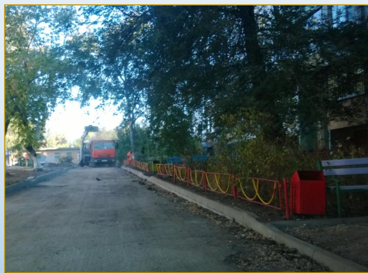
Фото объекта «В работе»
