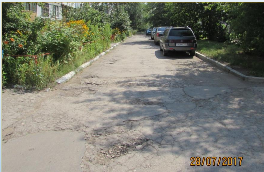
Фото объекта «До»
