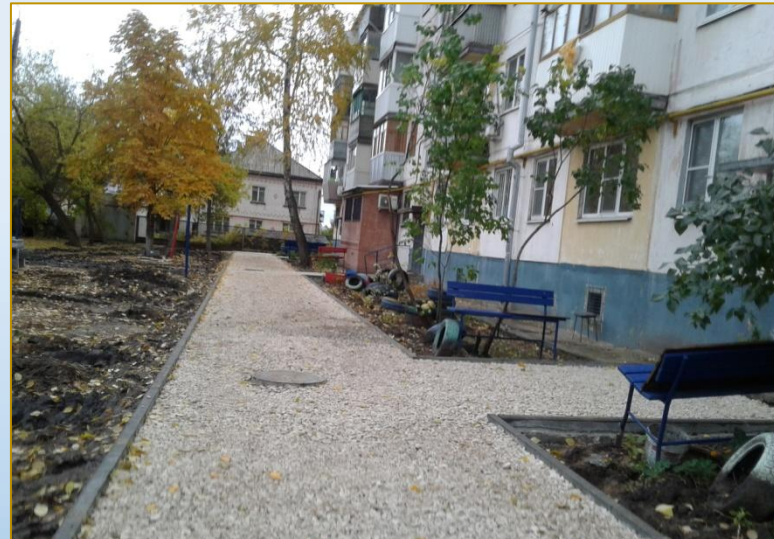
Фото объекта «В работе»
