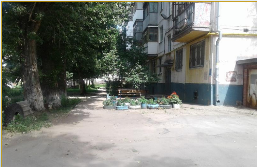
Фото объекта «До»
