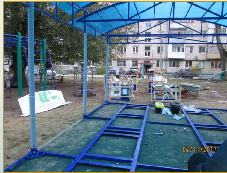
Фото объекта «В работе»
