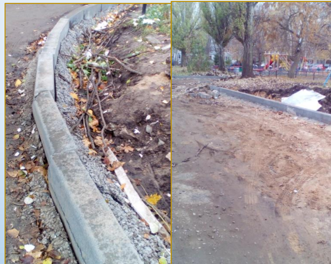
Фото объекта «В работе»
