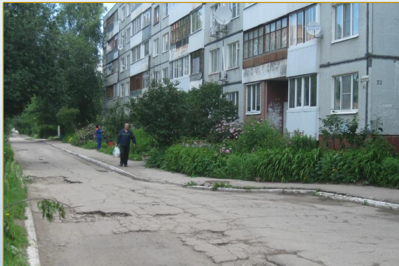
Фото объекта «До»
