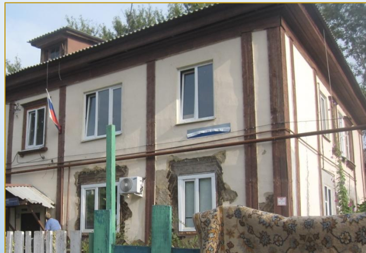
Фото объекта «В работе»
