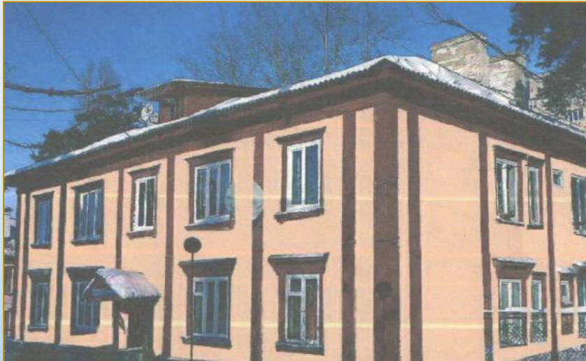
Фото объекта «До»
