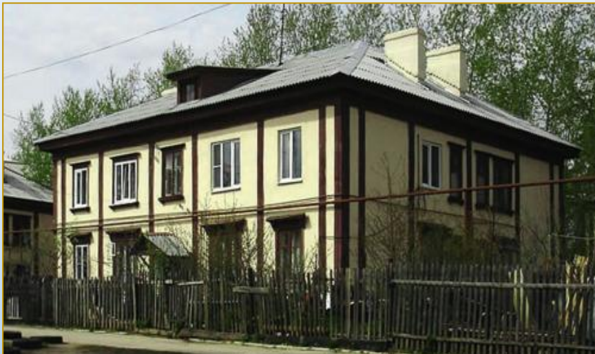
Фото объекта «До»
