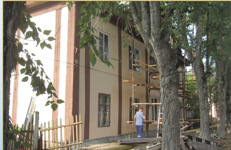
Фото объекта «В работе»
