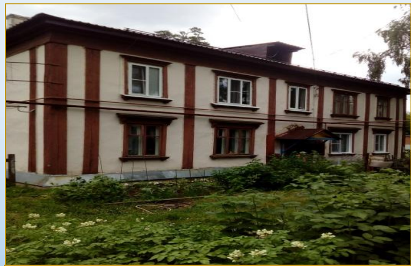
Фото объекта «До»
