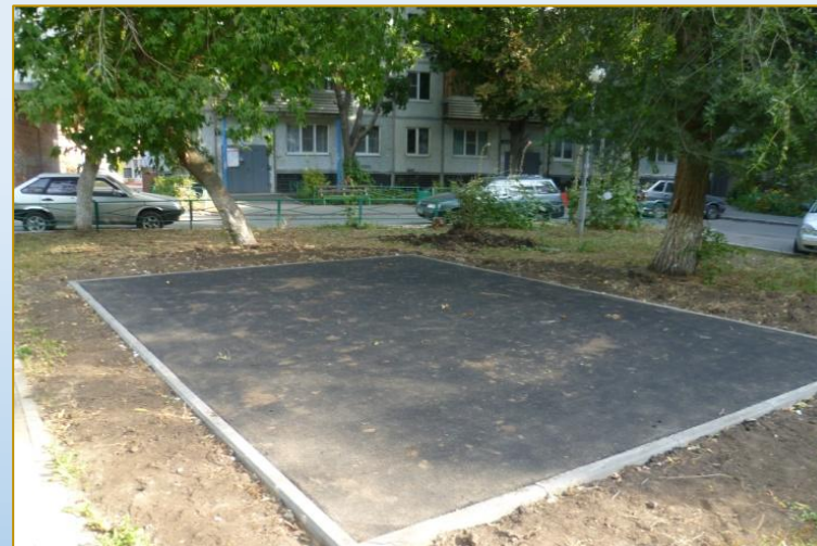
Фото объекта «В работе»
