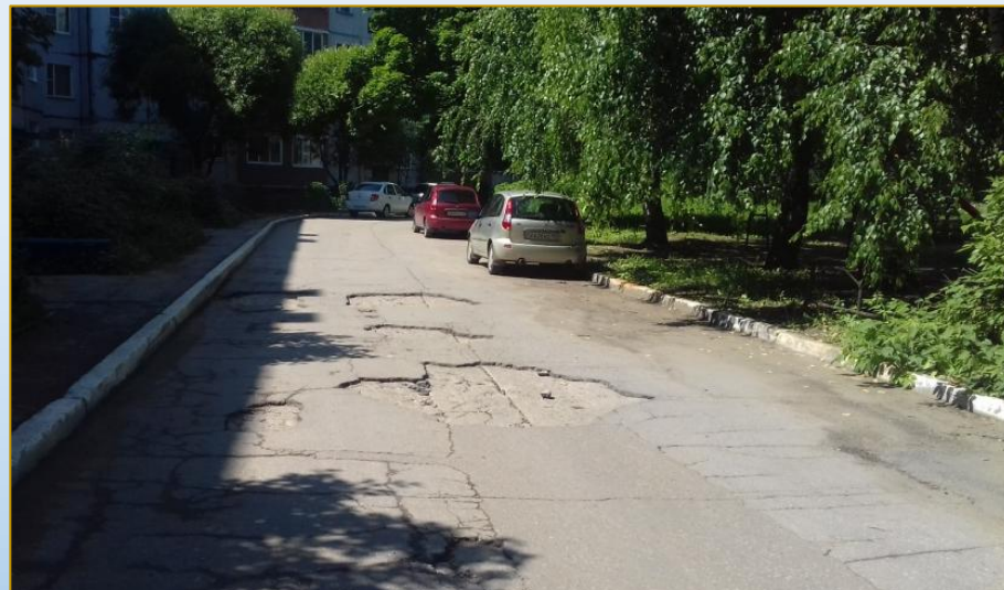
Фото объекта «До»
