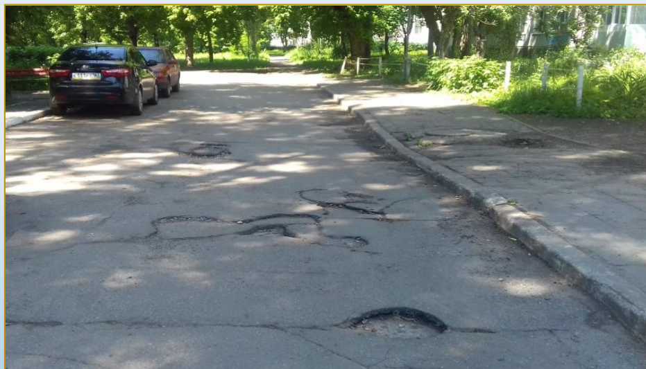
Фото объекта «До»
