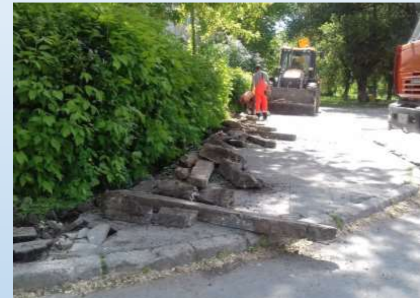
Фото объекта «В работе»
