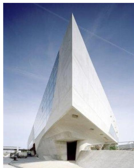
Об этом своём проекте Заха Хадид сказала так: «Фэно» – это наиболее законченное изложение моих поисков комплексности, динамики, многослойности архитектурного пространства». Здание, сооружённое из монолитного и самоуплотняющегося бетона, снаружи выглядит чистым и несокрушимым кристаллом, застывшем на фоне неба. Все перетекающие пространства «королева кривой», как называют Хадид, заключила внутри «Phaeno», покоящегося на массивных трапециевидных устоях.
