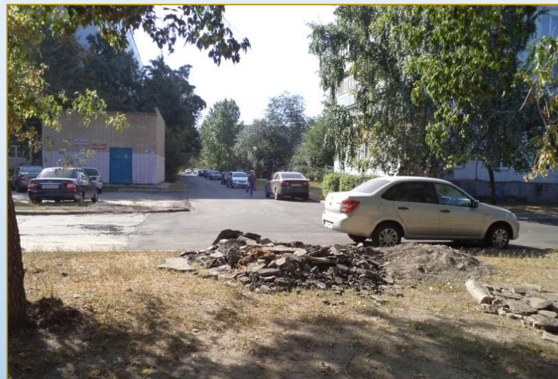
Фото объекта «В работе»
