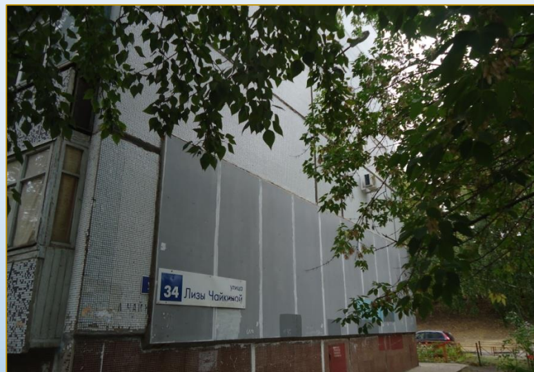
Фото объекта «В работе»
