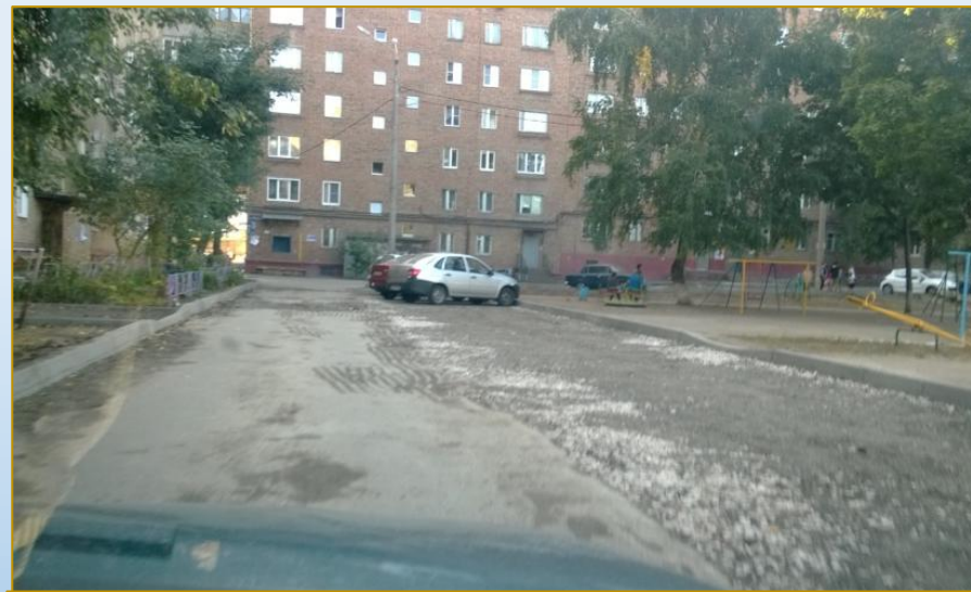
Фото объекта «В работе»
