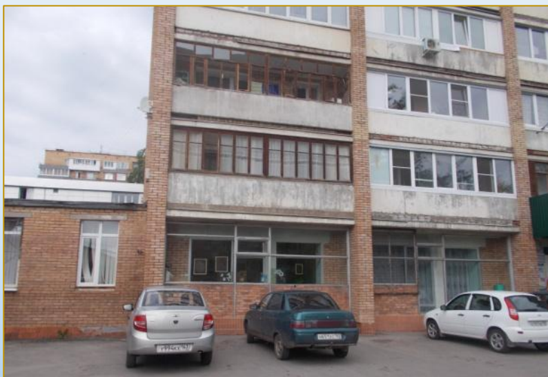
Фото объекта «До»
