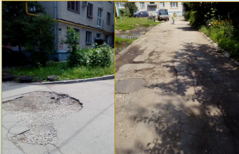
Фото объекта «До»
